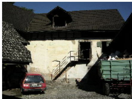
25. Eiskellergebäude von Süden, 2008
